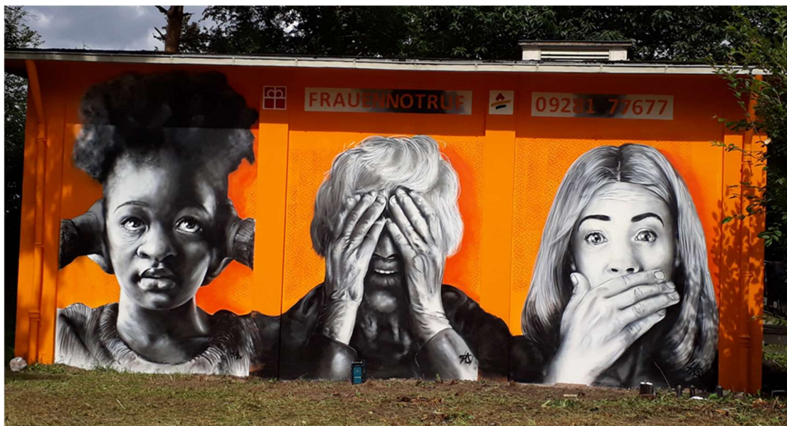
Gestaltetes Stromhaus der Stadtwerke durch den Künstler >Kasi<
